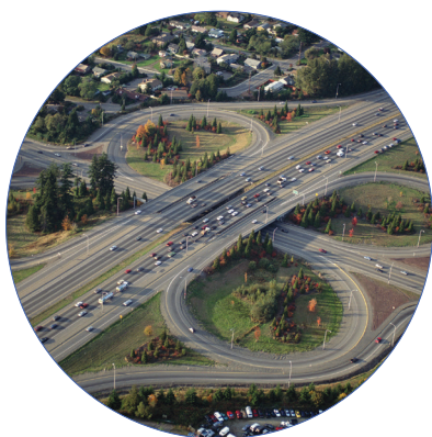
Monitoramento de ruído de tráfego
